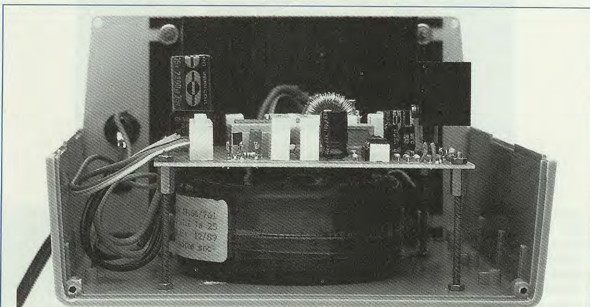
Fig.8 Il trasformatore toroidale andrà saldato sul piano base del mobile plastico, poi sopra a questo, con quattro viti distanziatrici, andrà fissato il circuito stampato LX.976. Le prese di uscita, sia per il trasduttore che per i due sensori, l'interruttore di rete ed il diodo led sono posti sul pannello frontale (vedi fig.9).
